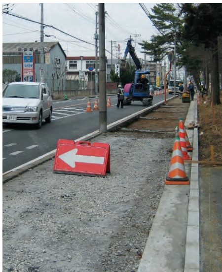
▲KCフォーム施工
