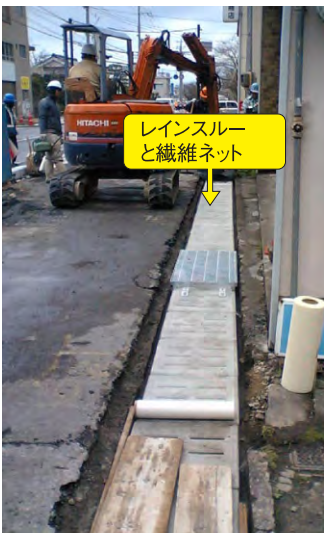
▼施工中(繊維ネット敷設)
