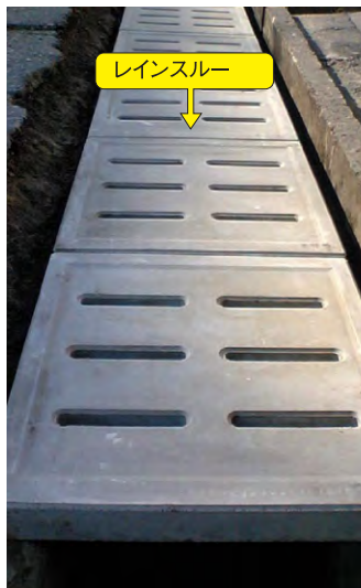
▼施工中(レインスルー敷設)
